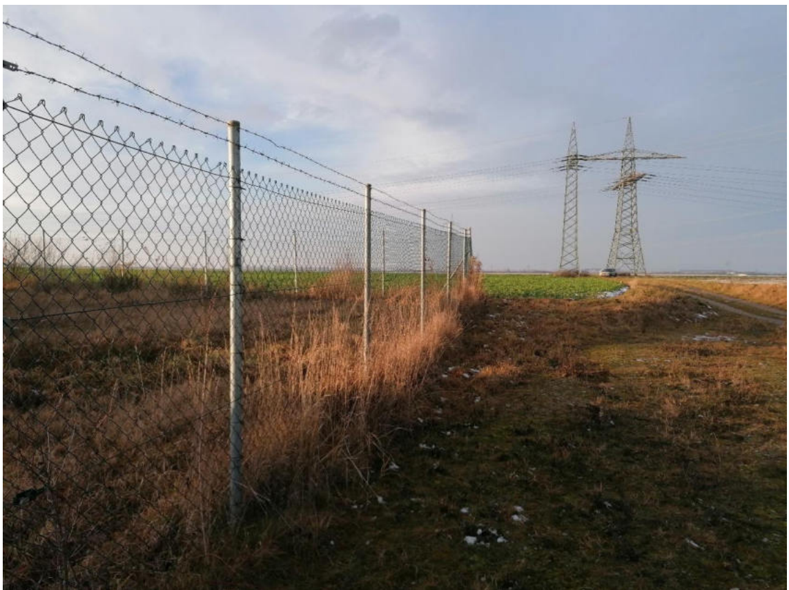
Blick in Richtung Norden, eigenes Bildarchiv 2022
